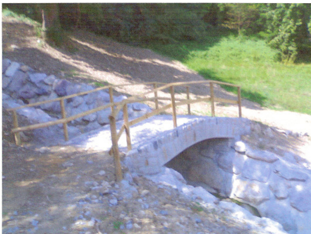
Regimazione delle acque e ponte verso la Torre
