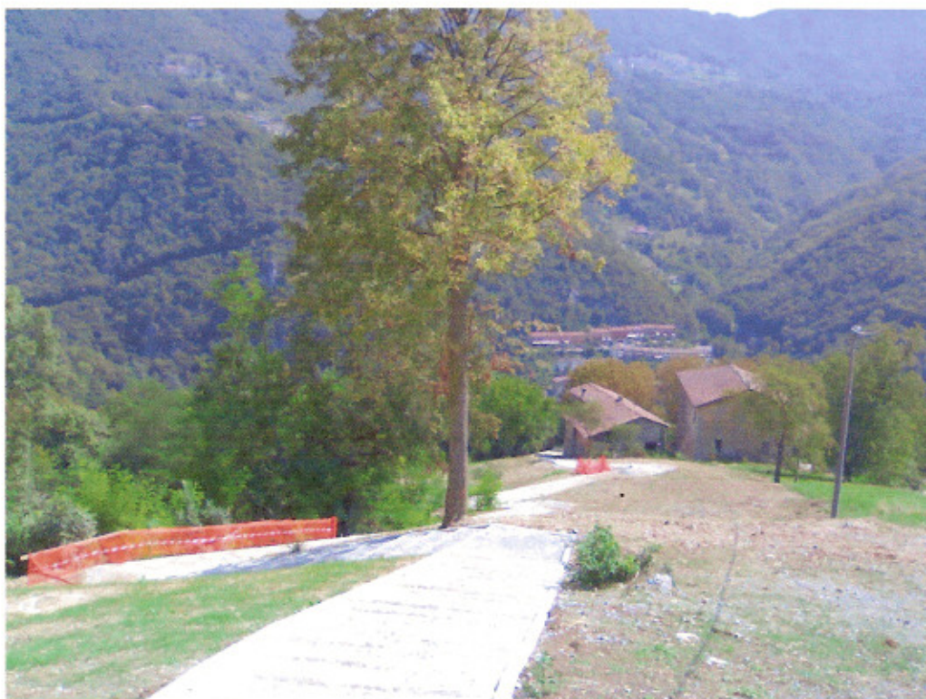
Scalinata da Aplecchio al Paradiso
